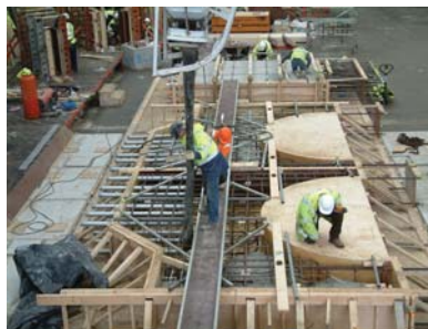
The pour gets underway
